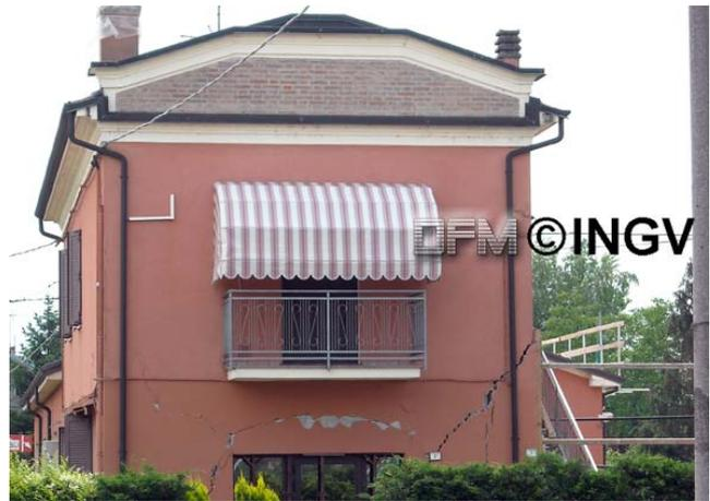
Foto 4. Canaletto. Crepe larghe e profonde. Danno di grado 3 in edificio di tipo B
