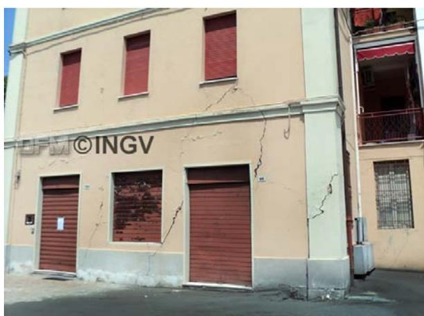
Foto 9. San Carlo. Crepe larghe e profonde in edificio di tipo B. In basso si notano effetti di liquefazione
