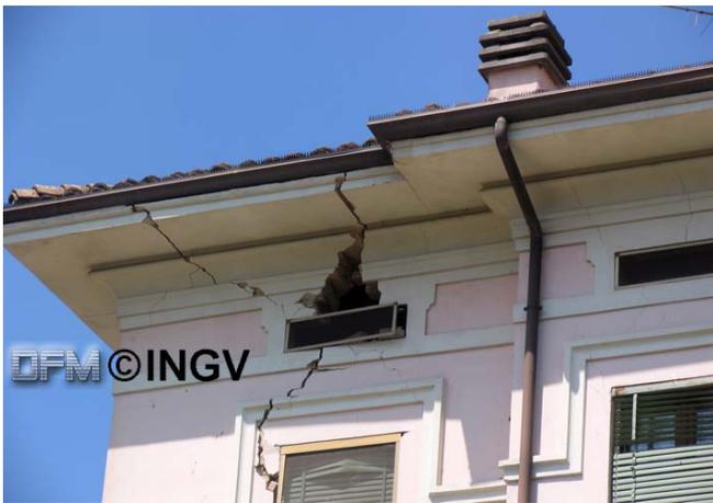
Foto 3. Reggiolo. Crepe larghe e profonde. Danno di grado 3 in edificio di tipo B
