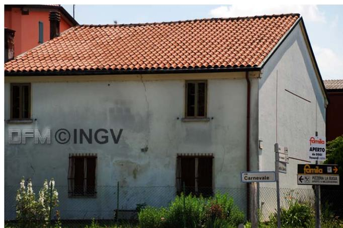
Foto 8. Poggio Rusco. Crepe diffuse in edificio di tipo B (danni di grado 2)
